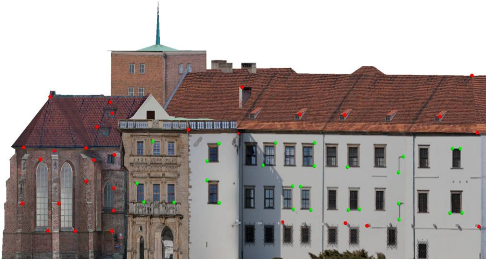
Rys. 6. Rozmieszczenie pomiarowych punktów kontrolnych. Kolor czerwony – elementy wektorowe modelu, kolor zielony – elementy tekstur
